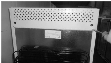
1. Beide Schrauben entfernen. (TX20).
