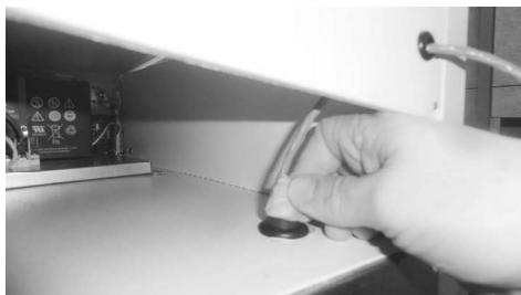
5. Verschließen Sie die Kabeleinführung mit Kitt, innen und außen.
